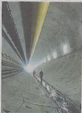
Sotto La galleria scavata
